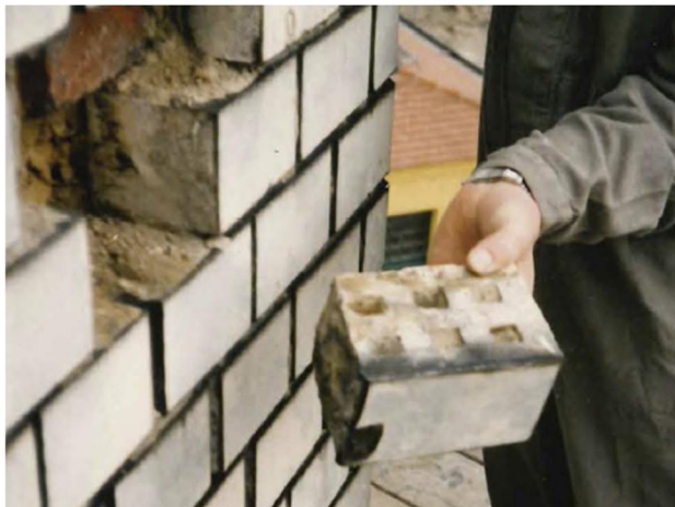
Bild 4: Schädelle mit entnommenem Verblenderziegel ([3])
