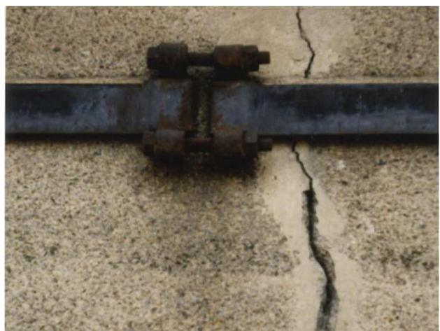
Bild 9: Vertikallriss im Betonsockel ([3])
