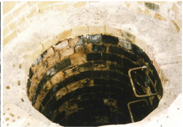
Bild 13: Sicht nach Innen mit fehlender Schamottschicht ([9])
