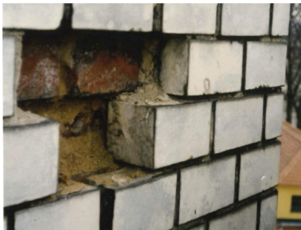
Bild 8: Schäden an der Außenschale ([3])
