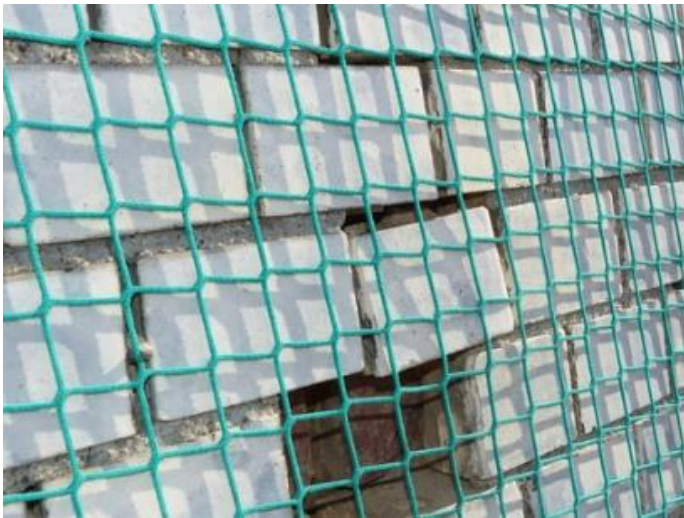
Bild 10: MS 1.4, Altmörtel ausgewaschen, Steine locker oder bereits herausgefallen
