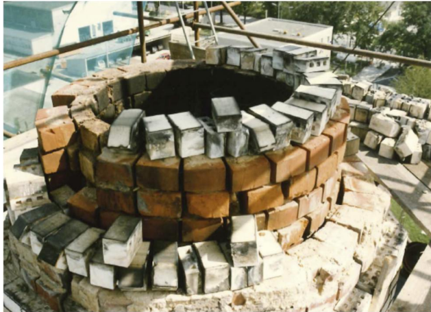
Bild 10: Neuaufmauerung Kopf 1992 ([8])
