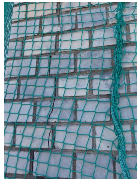
Bild 03: Vertikalriss
