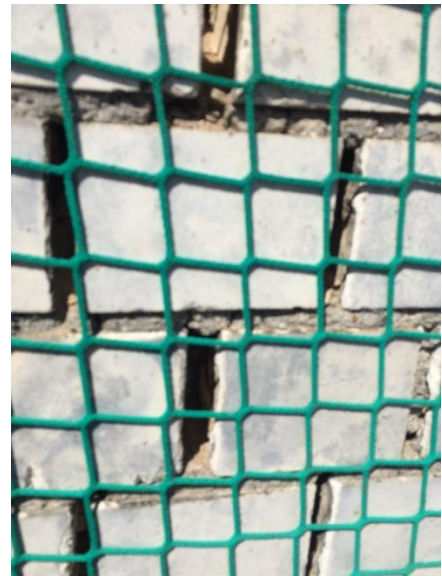
Bild 02: ausgewaschene Fugen
