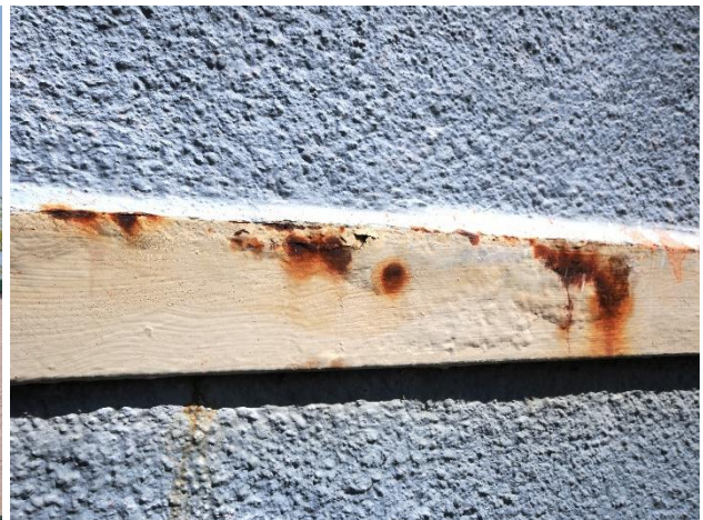
Bild 21: Blattrrost mit beginnendem Querschnittsverlust
