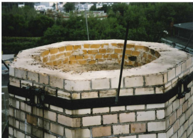
Bild 12: Schornsteinkopf mit rückgebauter Abdeckung ([9])
