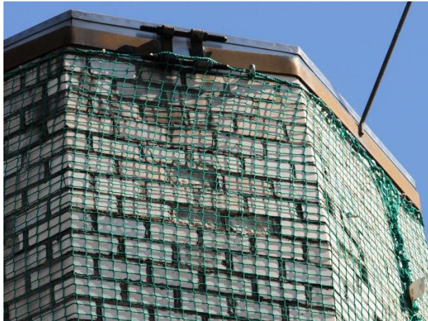
Bild 22: Schornsteinkopf mit abgeplatzten Ziegelschalen
