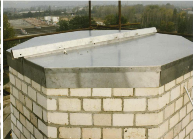
Bild 11: fertiggestellter Schornsteinkopf mit geschlossener Abdeckung ([8])
