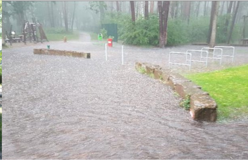
Regenwasserspielplatz in Neugraben-Fischbek als Flutmulde und Rigole für die Versickerung
